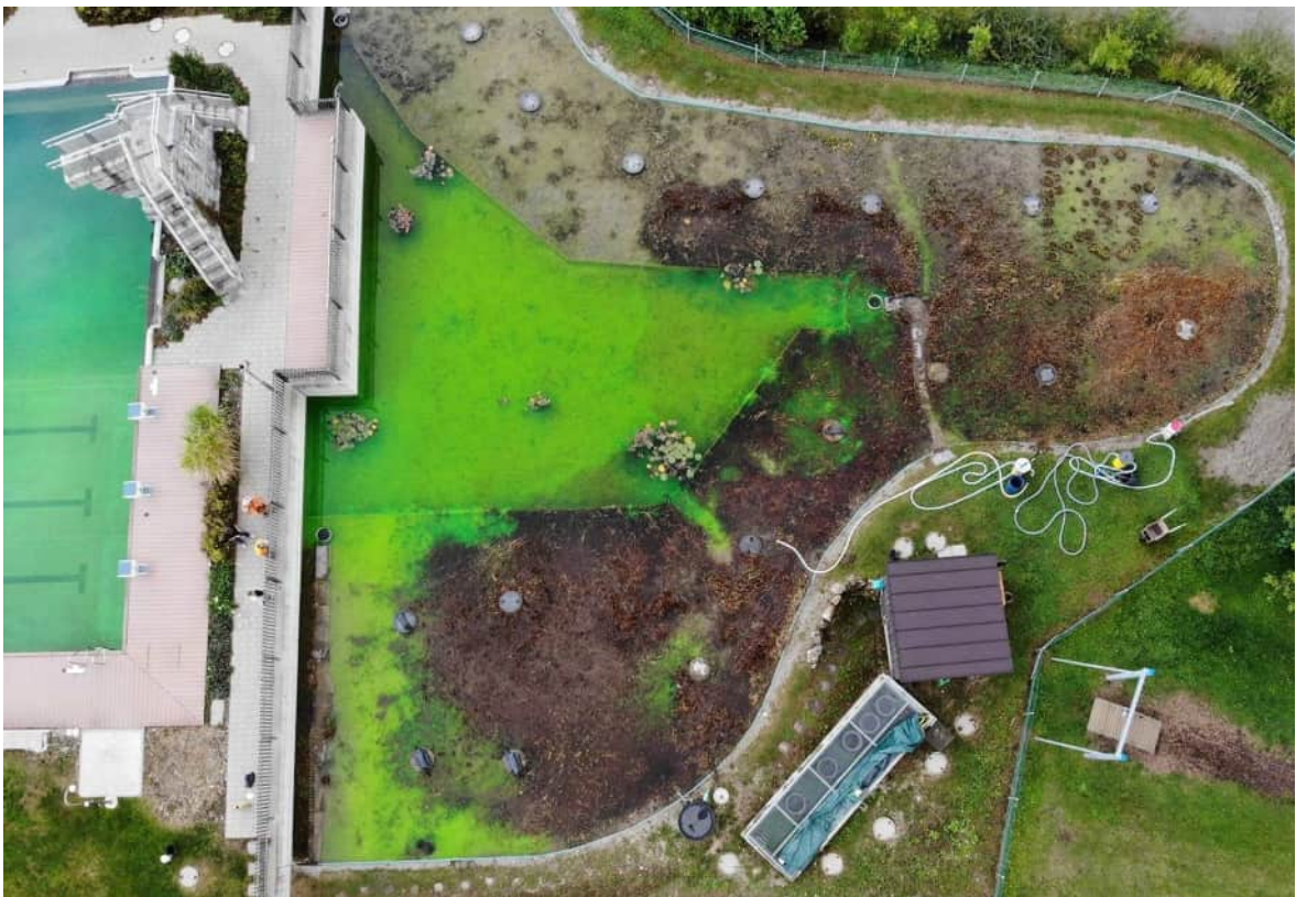
Abbildung 14: Färbetest mit Uranin im Pflanzensandfilter, vollflächige Anwendung über Einlauf-Sammelschacht, 16.09.2021
