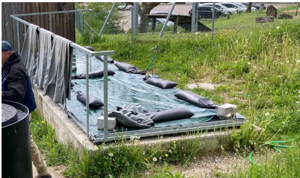
Abbildung 15: Bestehendes Betonbecken mit Filtersack-Einsätzen
